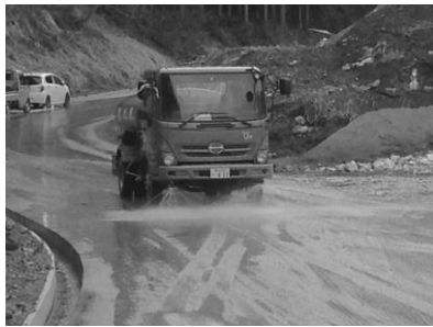
工事車両と大型ダンプ車が行き交う道路
