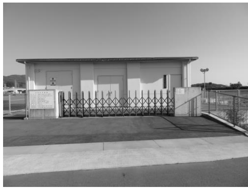
二タロ小水力発電所
